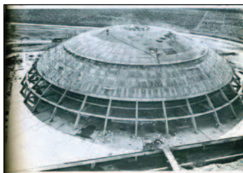
Le Palais des Sports en chantier
