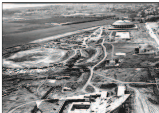
Travaux de construction des installations sportives
